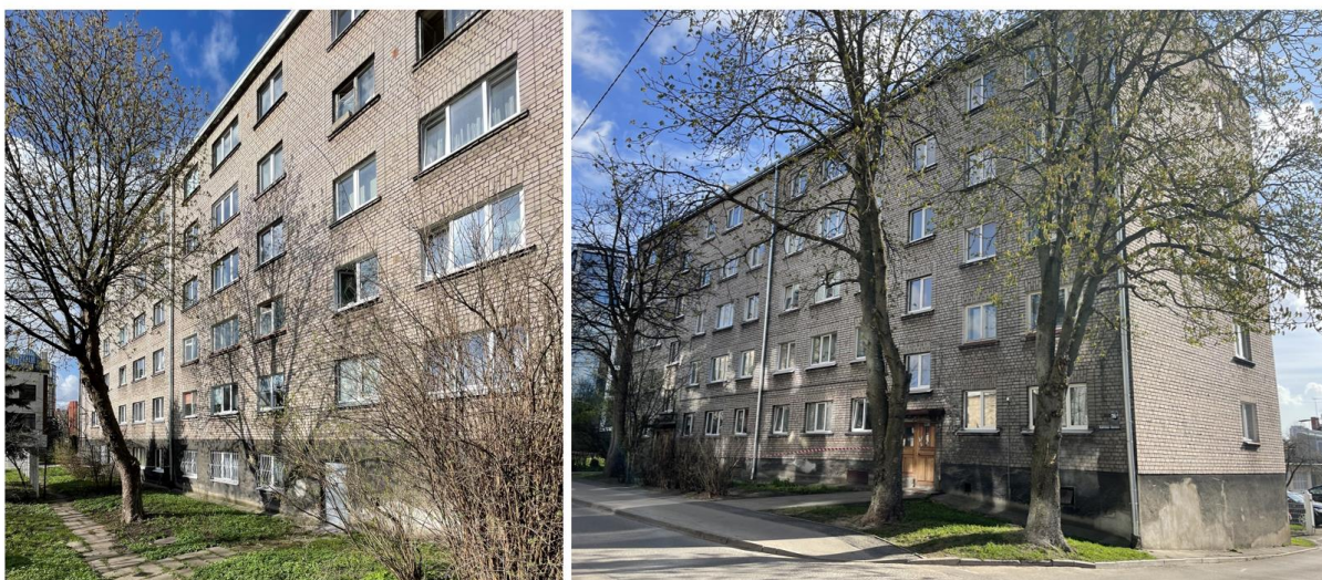
3.3. attēls. Daudzdzīvokļu dzīvojamā māja Katrīnas dambī 16A, Rīgā
